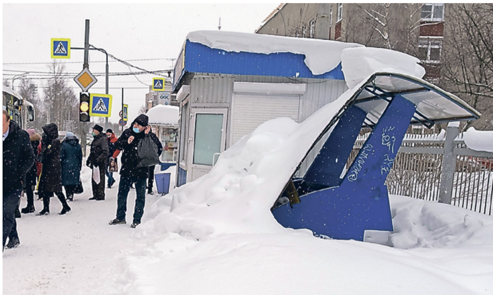
В центре города под тяжестью снега рухнула остановка общественного транспорта
